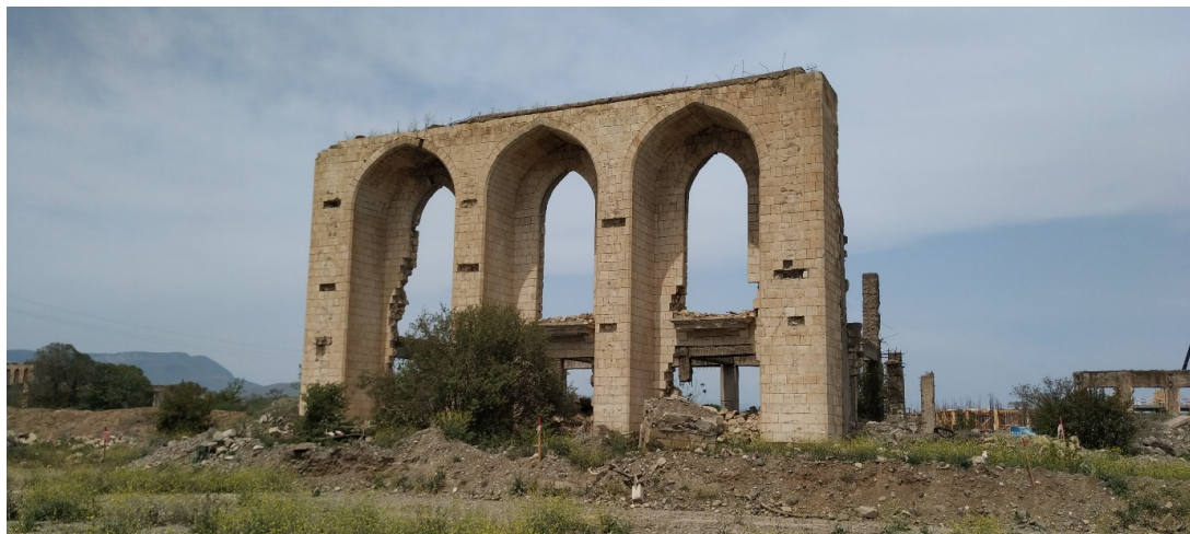
Obrázek 12. Fragmenty agdamské zástavby (budova bývalé Opery).
