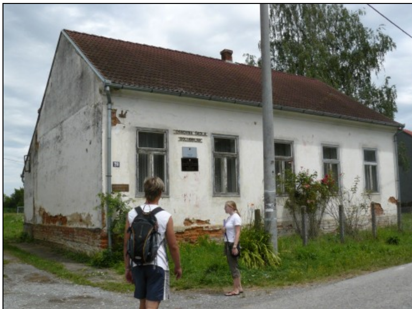
Obrázek 23. Bývalá česká škola v Holubňáku.
